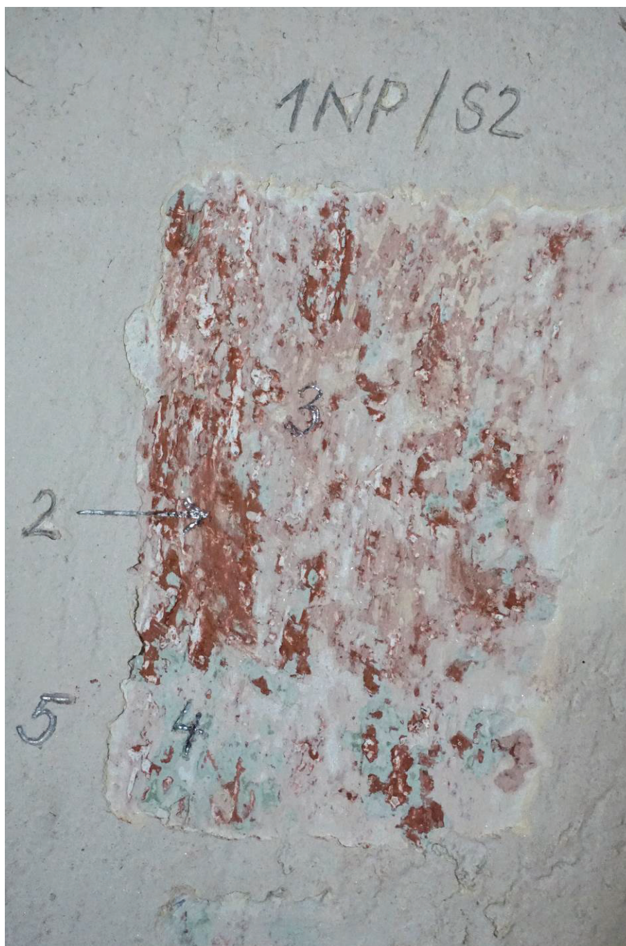
Obr. 18. Sonda 1NP/S2 na stěně. 2: Nejstarší dochovaná výmalba, pravděpodobně hlínková, v partiích stěn okrovočervená. 3: Hlínková výmalba růžová. 4: Hlínková výmalba světle zelená. 5: Současná novodobá výmalba.
