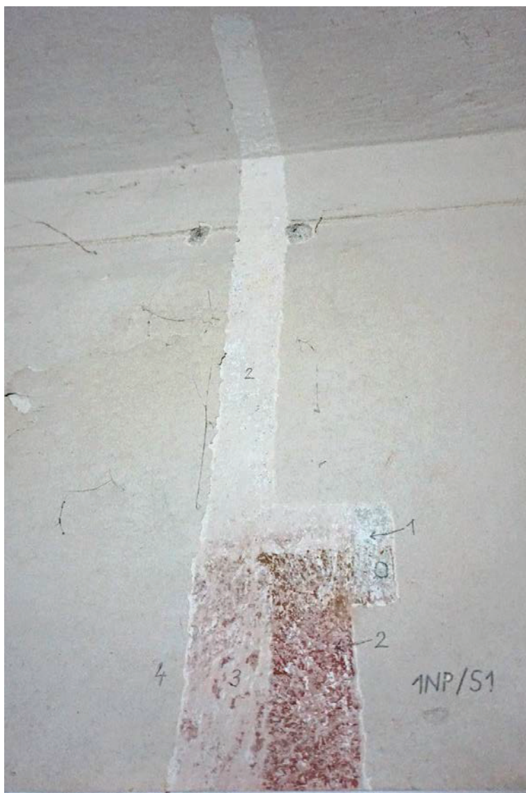
Obr. 17. Sonda 1NP/S1 na rozhraní stěny a stropu. O : Omítka. 1 : Vápenný nátěr. 2 : Nejstarší dochovaná výmalba, pravděpodobně hlinková, na stropě až do partií fabionů lomená bílá/ slonová kost a v partiích stěn okrovo-červená. 3 : Hlinková výmalba růžová. 4 : Současná novodobá výmalba.
