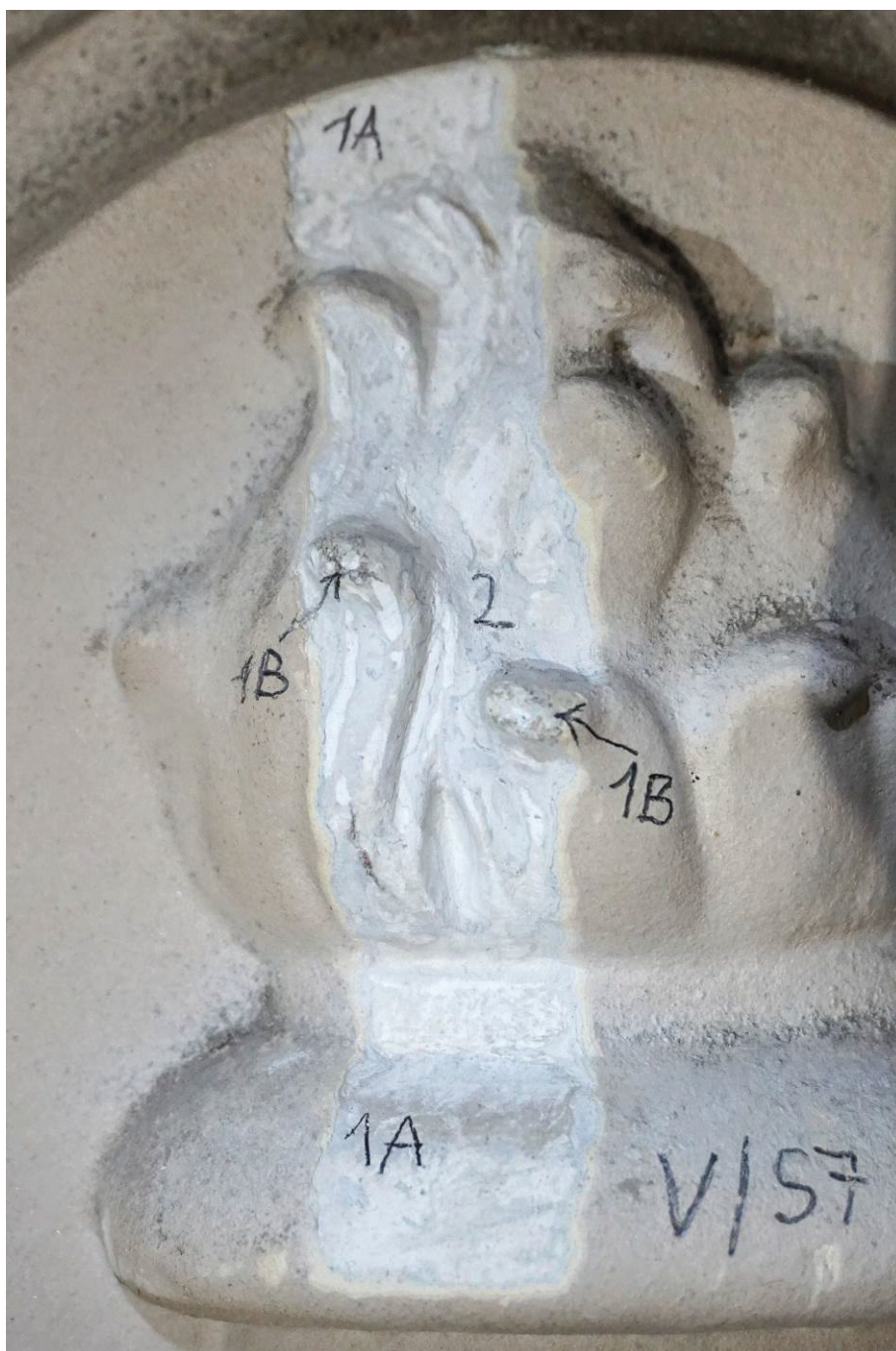
Obr. 10. Sonda V/S7 na pochodni. 1a: Nejstarší dochovaná barevná vrstva béžová. 1b: Fragmenty barevných okrovo-černých akcentů ve vrcholu plasticity. 2: Vápenný nátěr šedý.
