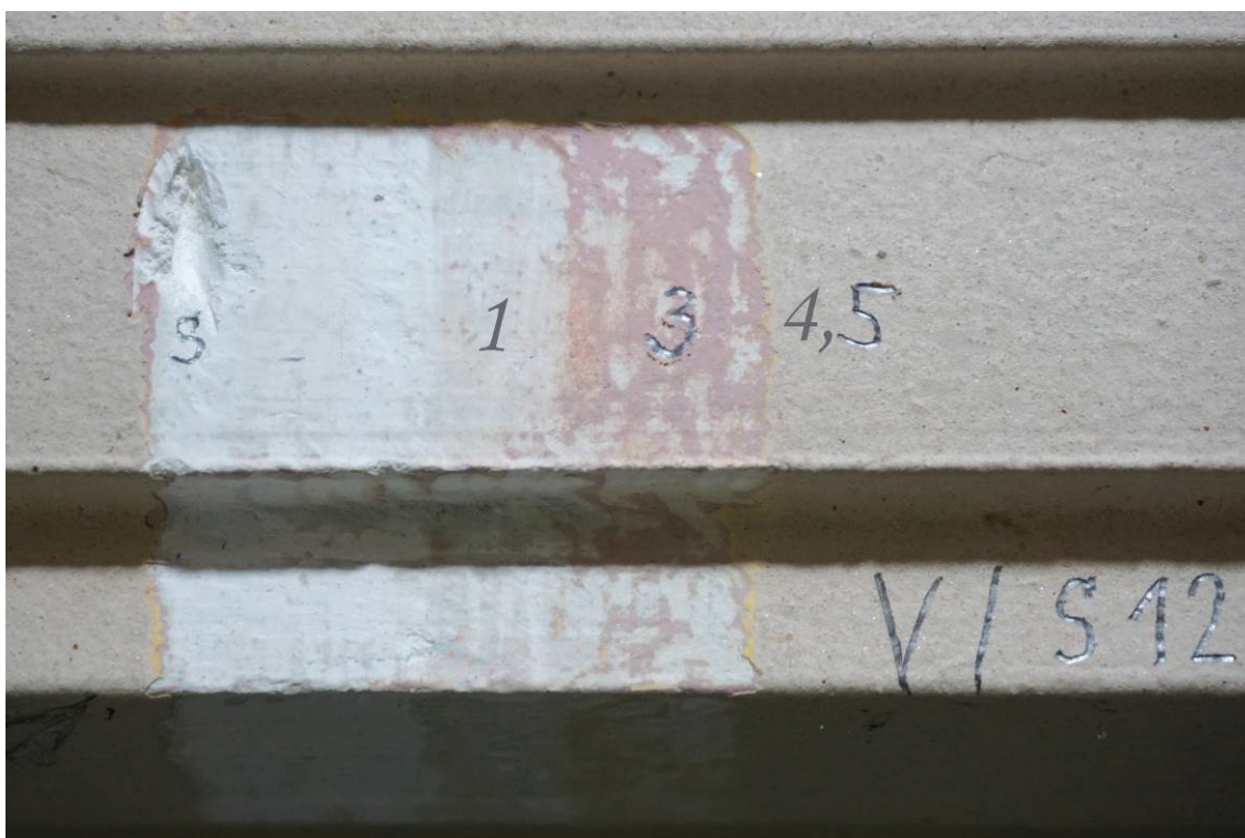
Obr. 15. Sonda V/S12 na stropě. S: Sádrový štuk 1: Nejstarší dochovaná barevná vrstva béžová. 3: Hlinková výmalba růžová. 4: Hlinkové výmalby a současná výmalba.
