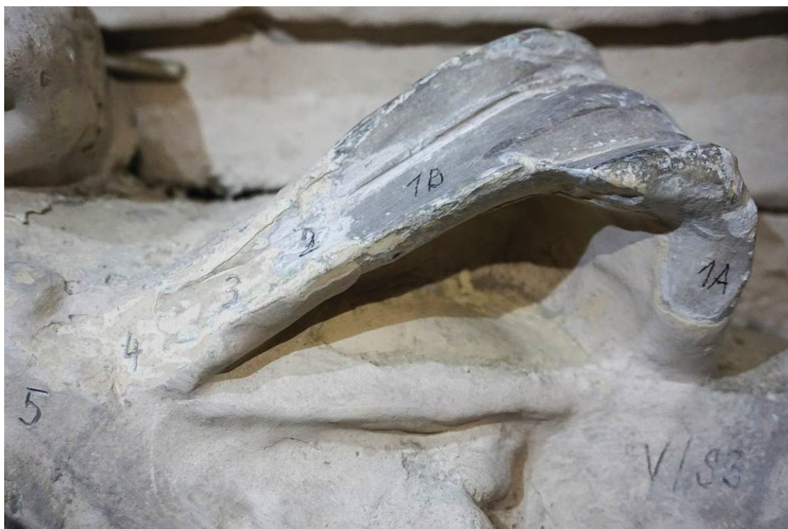
Obr. 6. Sonda V/S3 na stuze věnce. 1a : Nejstarší dochovaná barevná vrstva béžovo-šedá. 1b : Nejstarší dochovaná barevná vrstva tmavě šedá s okrovo-černými akcenty ve vrcholu plasticity. 2 : Vápenný nátěr šedý. 3, 4 : Hlinkové výmalby. 5 : Současná výmalba.
