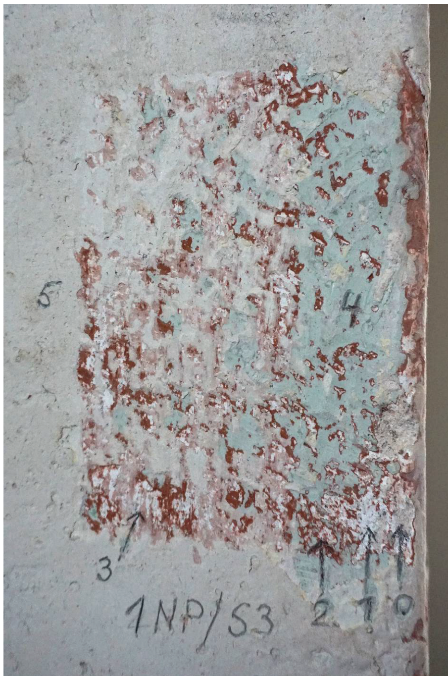
Obr. 19. Sonda 1NP/S3 na stěně. O : Omítka. 1 : Vápenný nátěr. 2 : Nejstarší dochovaná výmalba, pravděpodobně hlinková, v partiích stěn okrovo-červená. 3 : Hlinková výmalba růžová. 4 : Hlinková výmalba světle zelená. 5 : Současná novodobá výmalba.
