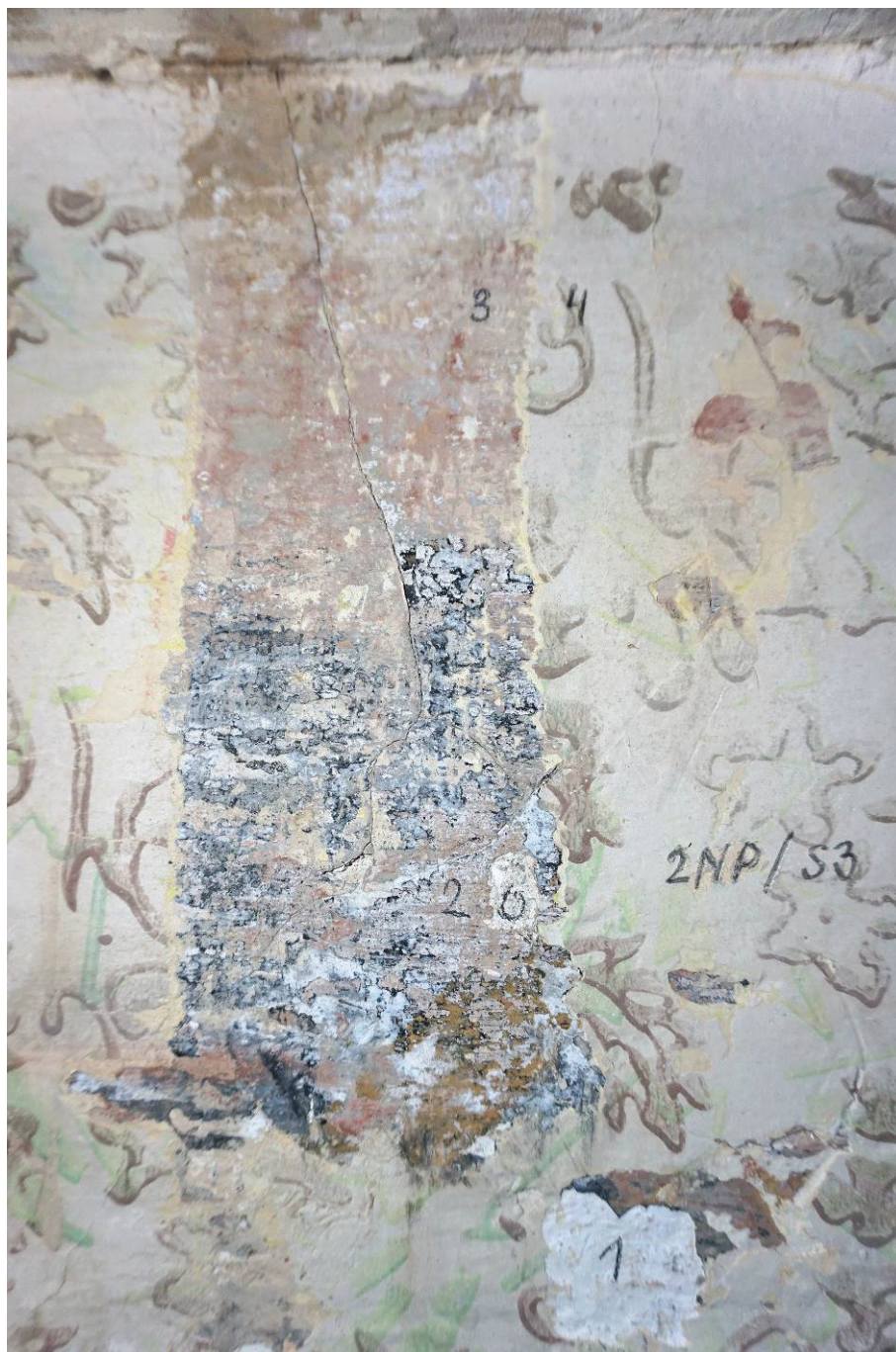
Obr. 23. Sonda 2NP/S3 na stěně v partiích soklu. O : Omítka 1 : Vápenný nátěr. 2 : Nejstarší dochovaná výmalba, pravděpodobně hlínková, v partiích soklu tmavě modro-šedé. 3 : Hlínková výmalba růžová. 4 : Současná novodobá výmalba.
