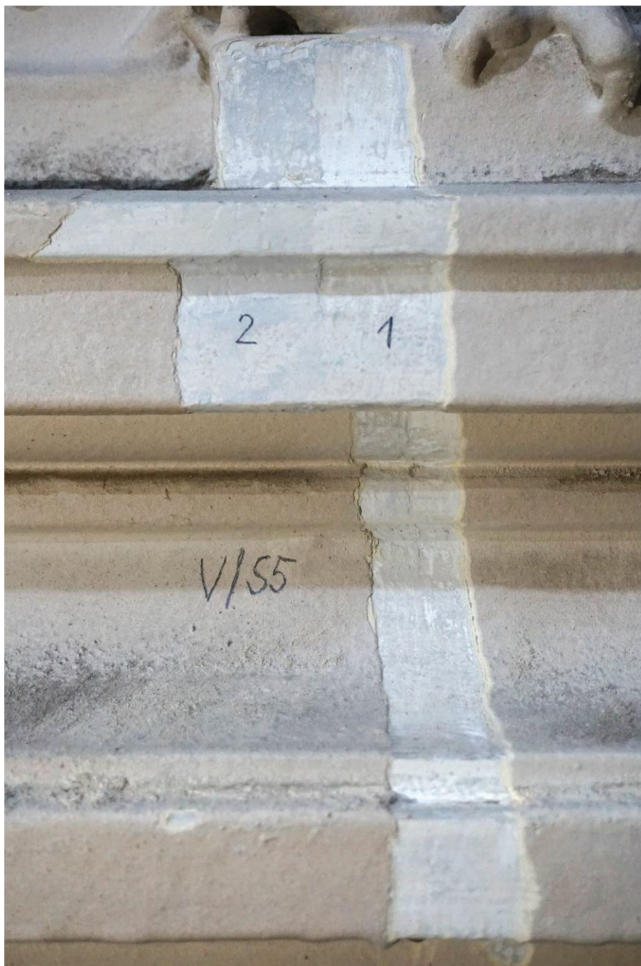
Obr. 8. Sonda V/S5 na architektonickém rámci. 1a: Nejstarší dochovaná barevná vrstva béžovo-šedá. 2: Vápenný nátěr šedý.
